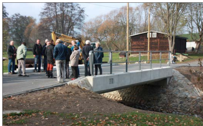
Verkehrsfreigabe der Finkenhübelbrücke, im Volksmund genannt „Schafbrücke“, am 10.11.2018 unter Beteiligung von Anwohnern und Gemeinderäten. Foto: Gemeinde Großschönau
