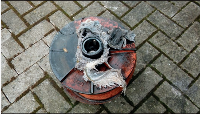
verstopftes Pumpenlaufrad durch Stoffreste bzw. Feuchttücher
