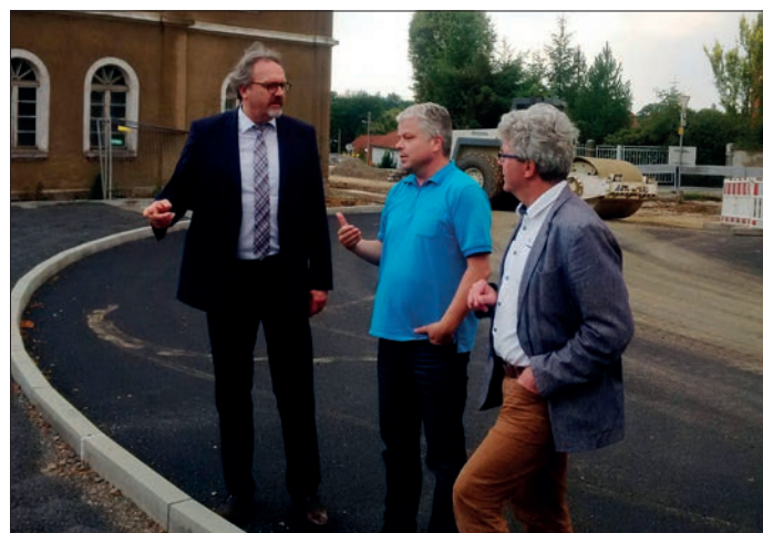
Staatssekretär Stefan Brangs (SMWA) überzeugt sich vom Bau der Übergangsstelle am Bahnhof Foto: Gemeinde
