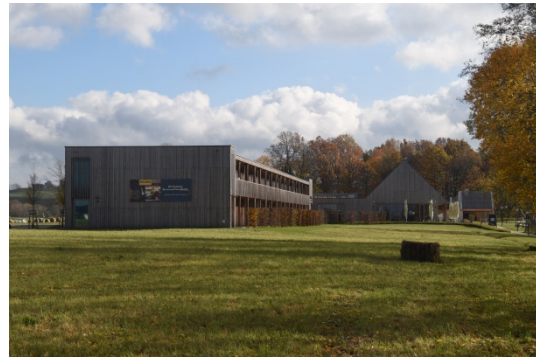
Hotel und Empfangsgebäude
