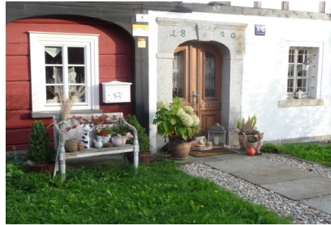
Sanierter Sandsteintürstock
