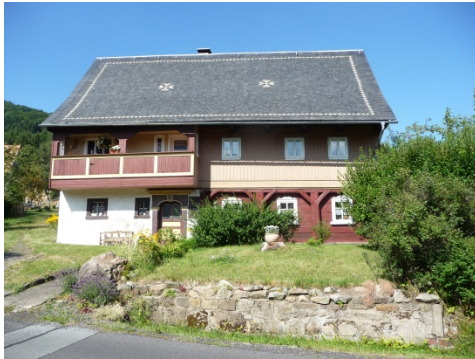
Umgebinderhaus Waltersdorf, Hauptstraße
