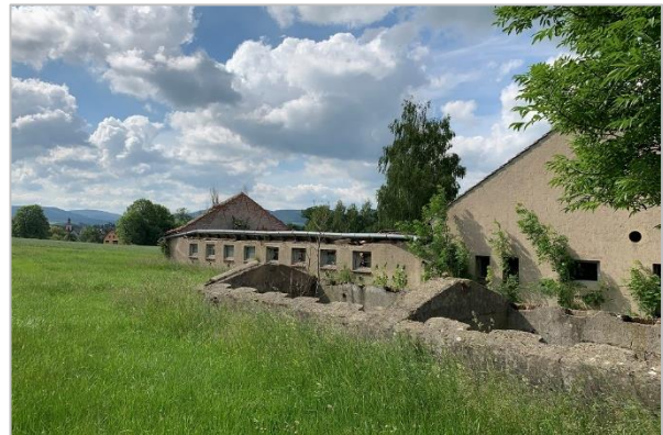
Abb. 7: Ehemaliges Silo (Blickrichtung Nord-Süd)
