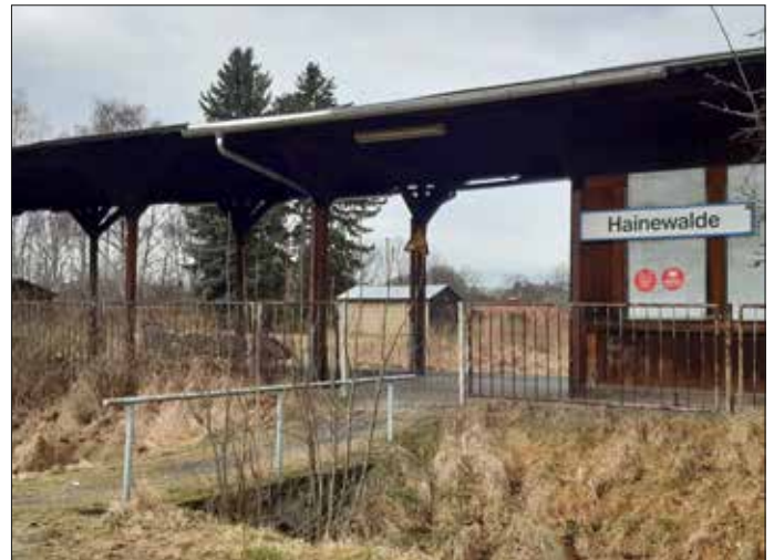
Der Bahnsteig in Hainewalde auf der Querwegseite soll künftig auf die Bahnhofseite verlegt werden. Foto: J. Walther
