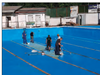
Das Schwimmbecken wurde frisch gestrichen. Fotos: Steffen Schmidt
