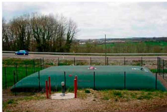
Oberirdische, faltbare Zisternen werden in Frankreich seit über 25 Jahren als Wasserreserven in der Brandbekämpfung hergestellt. © PR/Labaronne-citaf
