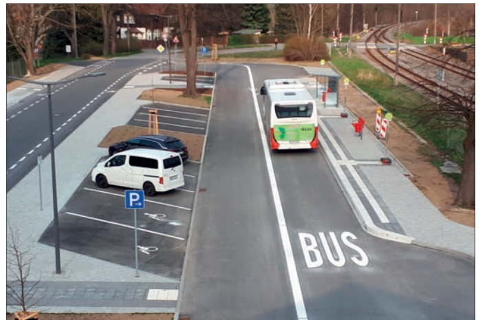
„Blick auf die neu entstandene Übergangsstelle Bus / Bahn am Bahnhof Großschönau“. Foto: Markus Hummel (Gemeinde Großschönau)
